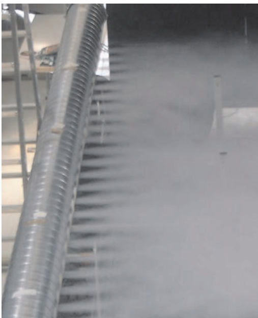
Rauchversuch am Düsenrohr
